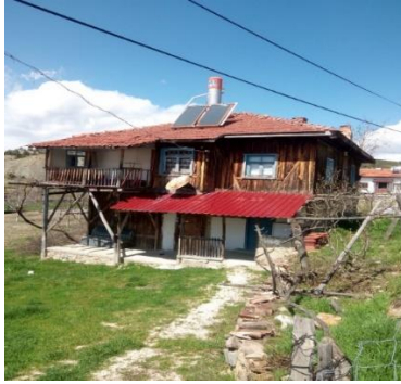
Resim 3. Belenören Mahallesiinde Geleneksel Bir Köy Evi
